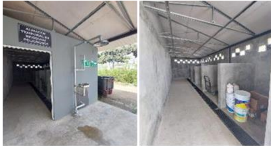
Figura 4. Almacén temporal de Residuos Peligrosos (RP) en Campus Ciudad de México.
